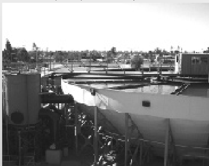
▲ Filtros de Planta No. 1
