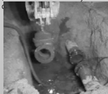
▲ Reposición de válvulas.
