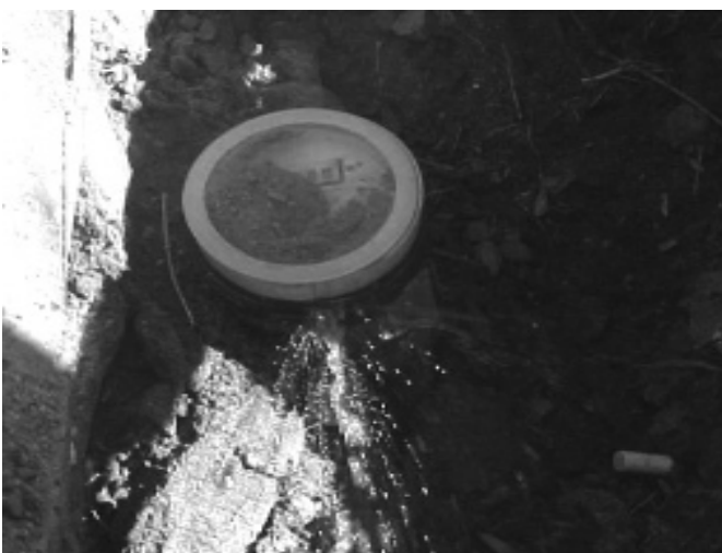
▲ Reparación de fuga.
