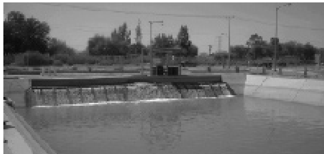
▲ Planta potabilizadora No. 3
