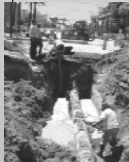
▲ Reposición de tubería.
