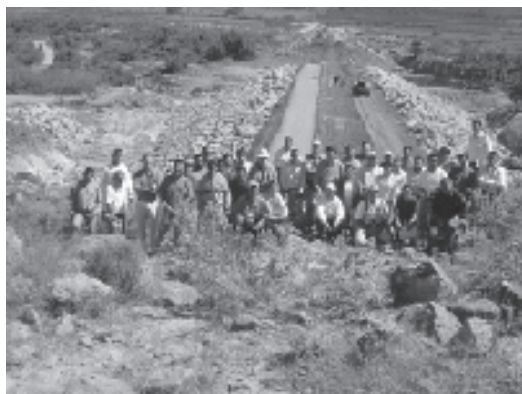
▲ Panorámica de la cortina de la obra en construcción (Presa de Ortega).
